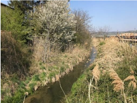
Der Göllersbach im Bereich des Bahnhofs: ein begradigter Abfluss. (Foto: GöFF, HK)
